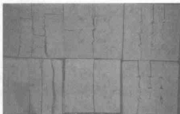
图5 模型试件 II 单压破坏情况
